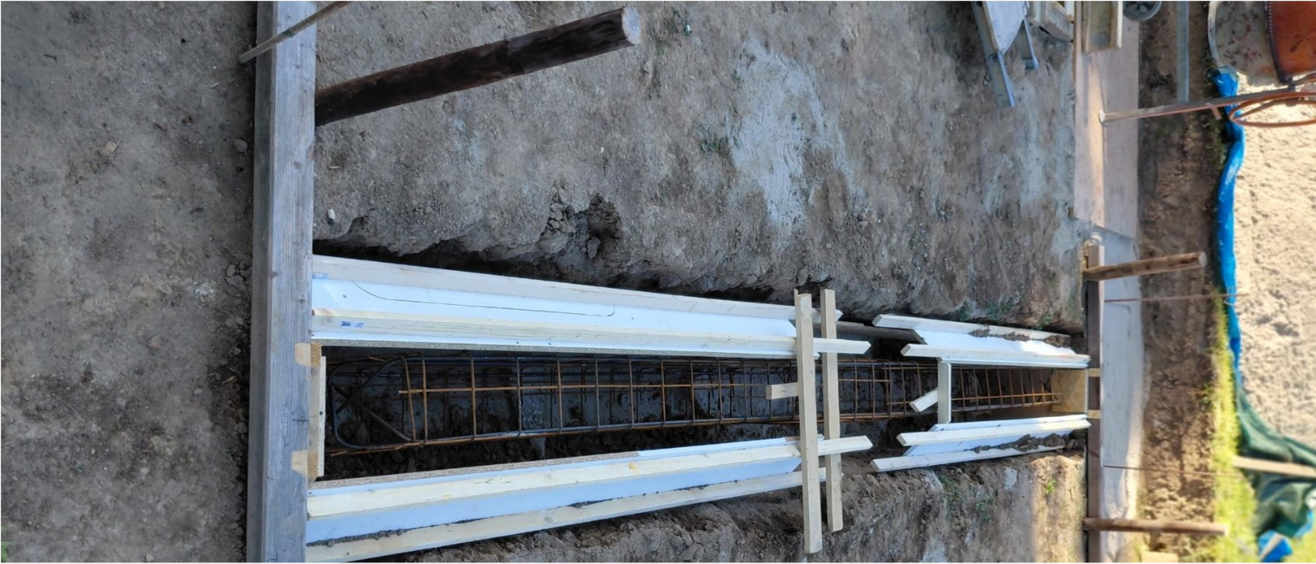
Schalung Fundament Calisthenics Anlage
